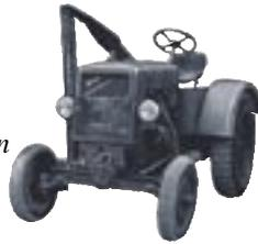
**1938** Dieselöl-Knappheit und Verbot des Einsatzes von Dieselschleppern führte zur Entwicklung des Holzgasgenerator-Schleppers mit 25 PS.
