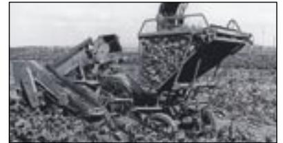
**1968** Farmer 3 S (48 PS) mit stufenloser Anfahrautomatik (Turbomatik) – seine Technik wurde zum Vorbild.
