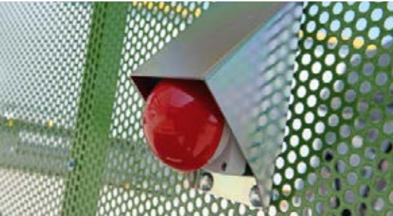
En valgfri akustisk nivåvarsler styres av en sensor på bakveggen.
